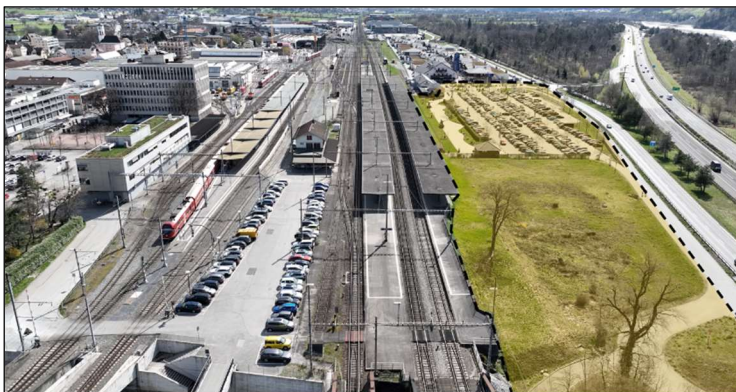
Abbildung links: Das Gebiet Tardis liegt westlich des Bahnhofs zwischen den Gleisen und der Nationalstrasse. Das Areal ist heute noch kaum genutzt und bietet ein massgebliches Entwicklungspotenzial. (Luftaufnahme R+K, Raumplanung AG)
