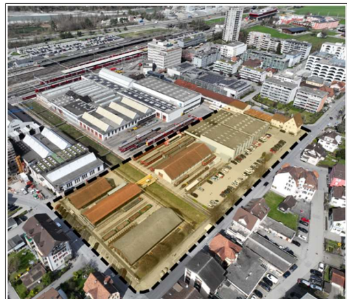
Luftaufnahme des RhB-Areals Schulstrasse (Quelle: R+K, Raumplanung AG)
